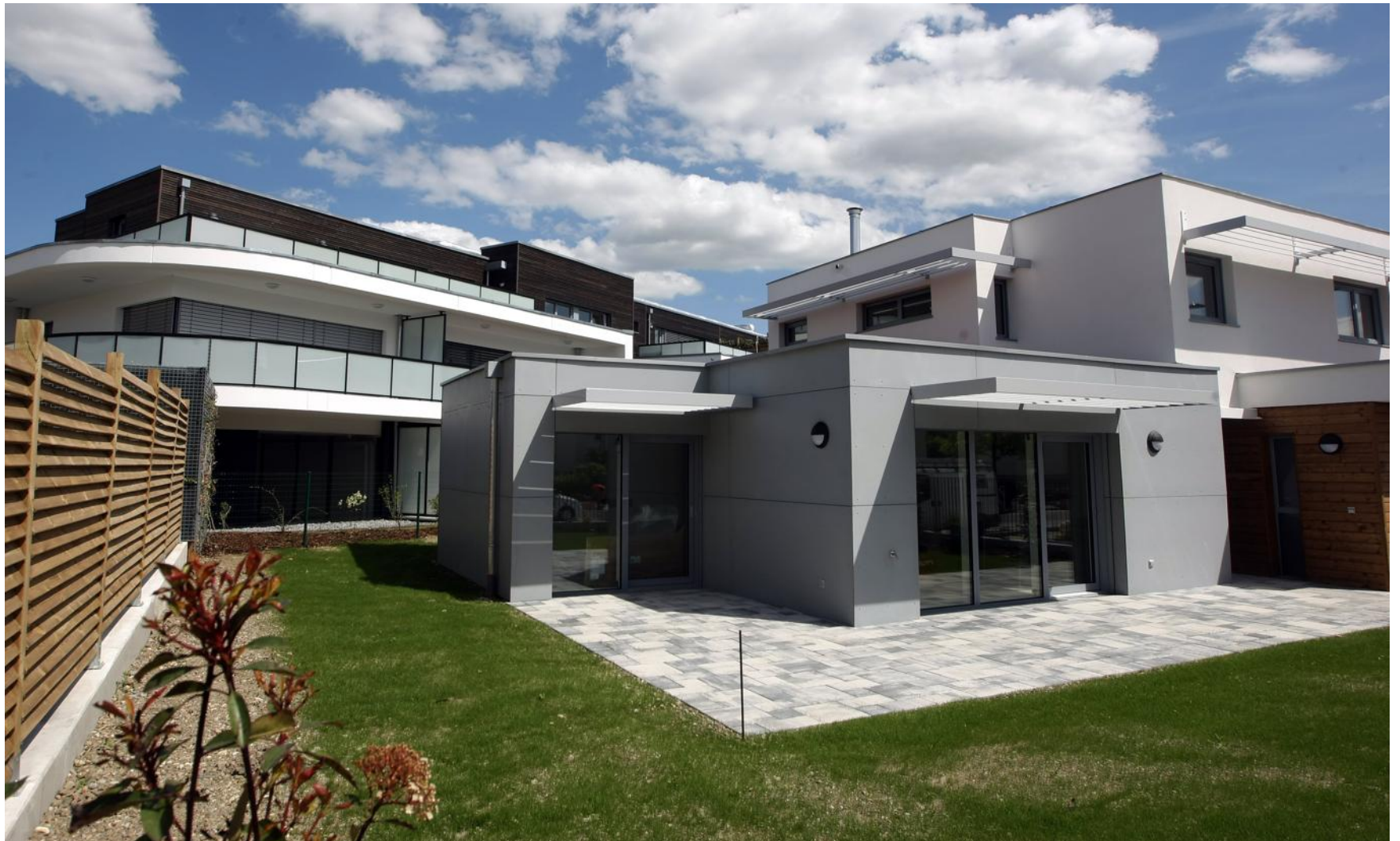
Au premier plan, une maison passive, de l'architecte Bertrand Fritsch, et au second, l'immeuble à énergie positive, dessiné par Anne-Sophie Kehr et Georges Heintz. PHOTO DNA - LAURENT RÉA
